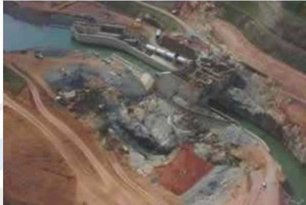
Figura 7 – Foto aerea da Construção da PCH Ivan Botelho II
